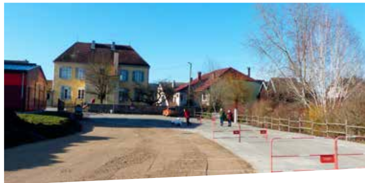
Une réalisation communale soutenue par la DST : l'esplanade en cours de matérialisation près de la nouvelle école de Sirod (lire également en page 18).
