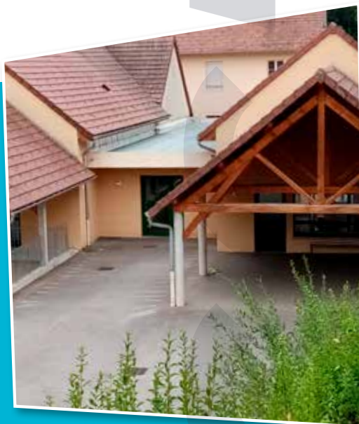
Travaux d'étanchéité au groupe scolaire du Rachet (Chaux-des-Crotenay).
