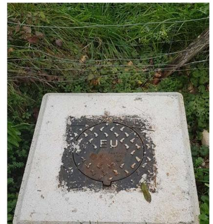
Figure 8: Boîte en limite, au-dessus du TN
