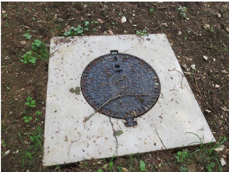
Figure 5: Dalle, d'un regard présent sur terrain naturel
