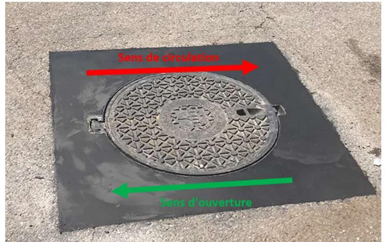
Figure 4: Préconisations pour le positionnement du sens d'ouverture d'un tampon EU
