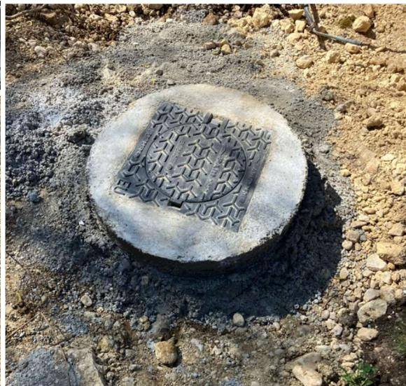
Figure 10: Béton de scellement et de propreté
