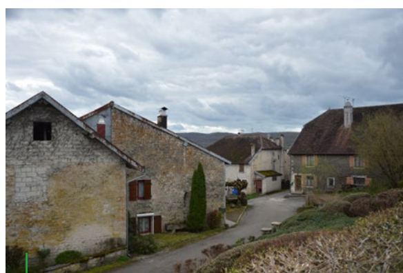
Crottenay, adaptation des constructions à la pente
