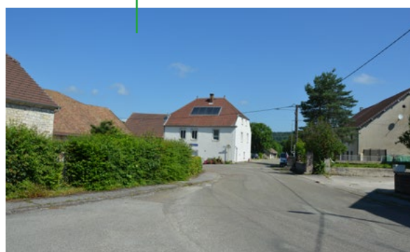
Rue des Epinettes, en 2024, l'espace entre le bâti et la rue est devenu privé
